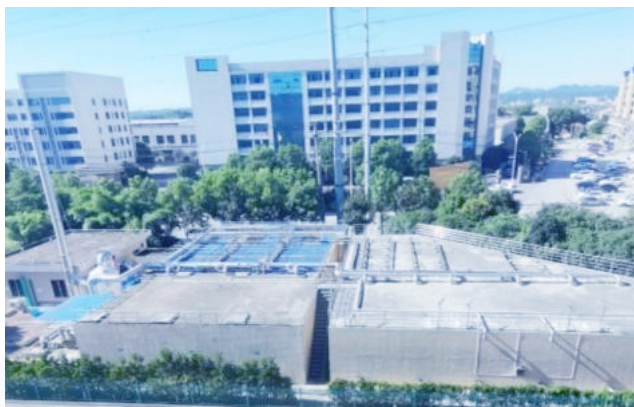
岳阳分公司污水扩容工程
